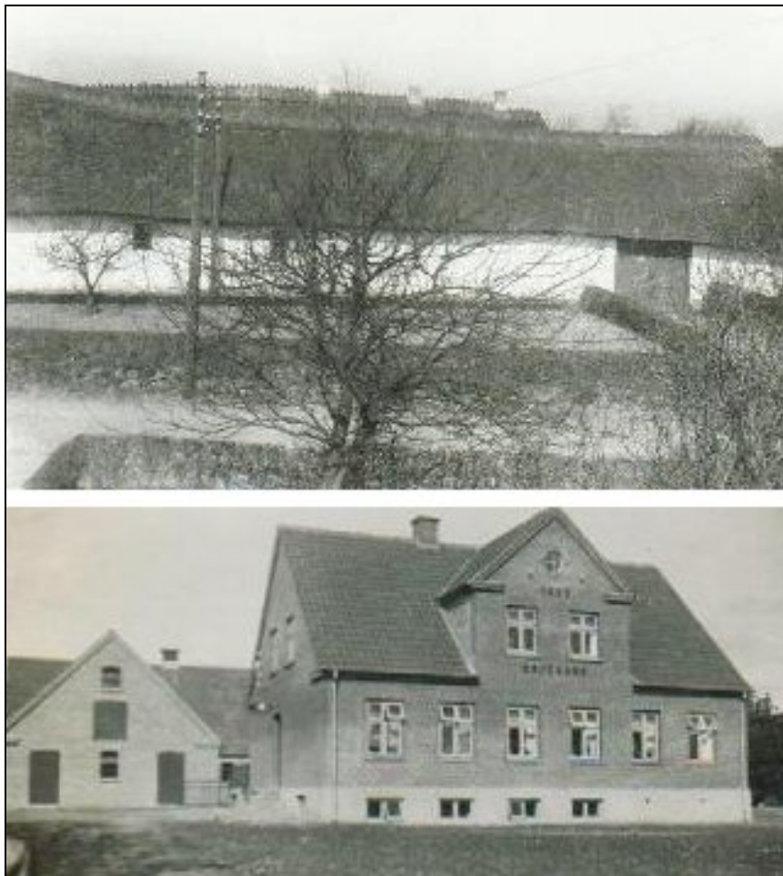
Højgård i Brylle, Ryttergade 20, matr.nr. 6a, før og efter branden
